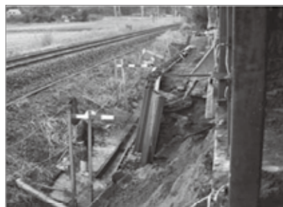
鉄道を保全する土留工
