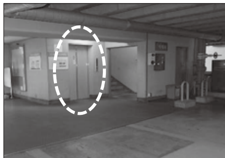
(駐車場内にエレベーターを設置)
