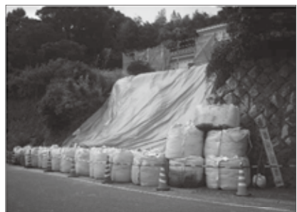
避難路を保全する土留工・排水工
