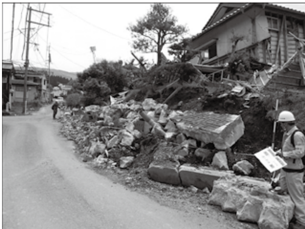
写真-2 宅地擁壁の被害（熊本地震）
