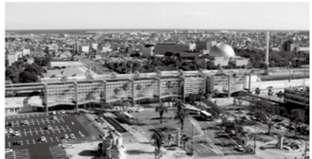
写真 宮崎地区連続立体交差事業（宮崎駅舎）
