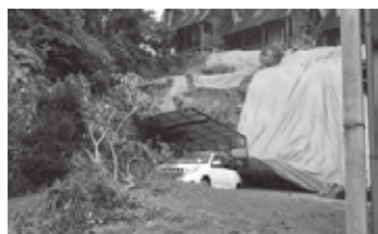
大規模造成宅地の滑動崩落
