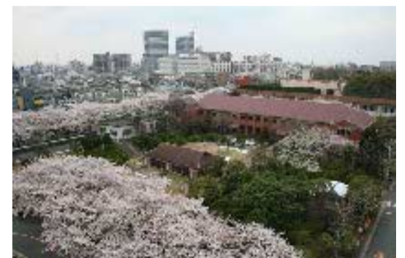
上記のうち今も残る 水再生センター 平成20年
